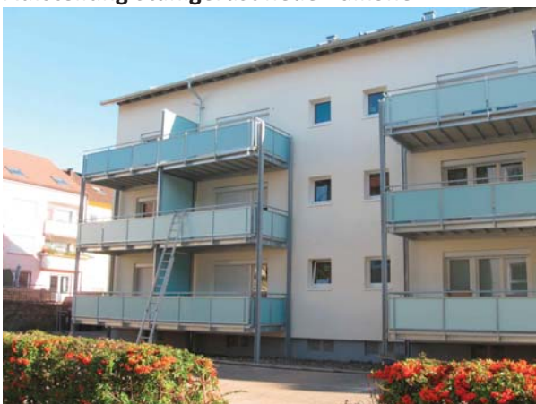
gedämmte Fassade mit neuen Stahlbalkonen
