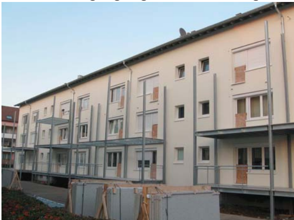
Aufstellung Stahlgerüst neue Balkone
