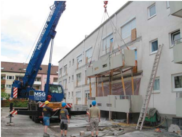
Fassadenbündig abgesägte alte Balkonanlage
