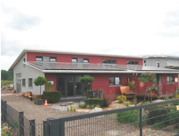
Südansicht mit Photovoltaik Anlage
