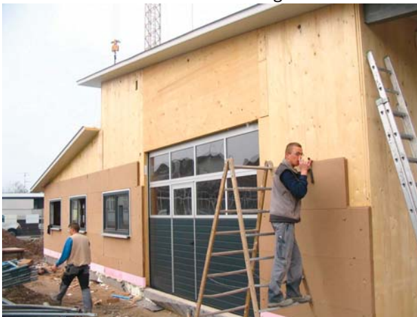
Ostansicht Aufbringen der Holzweichfaser Dämmung
