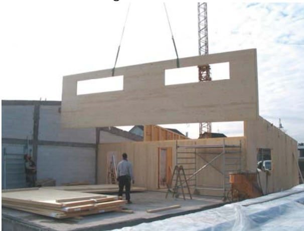
Montage der vorgefertigten Massivholz Wandelemente
